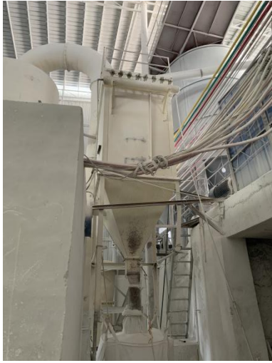
图1 脉冲袋式除尘器（破碎工序、雷蒙磨机 7#）
