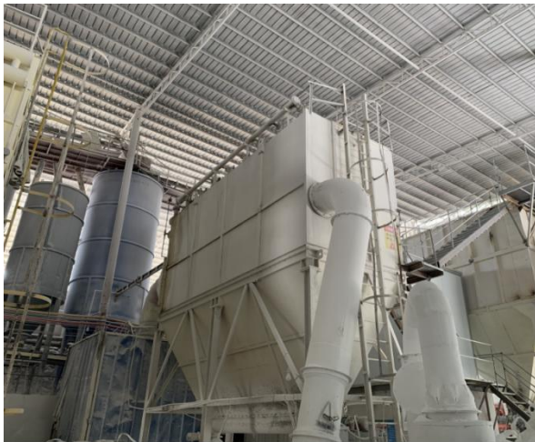
图3 脉冲袋式除尘器（雷蒙磨机 6#）
