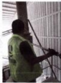
雷蒙磨机 2#废气 排放口 DA004
