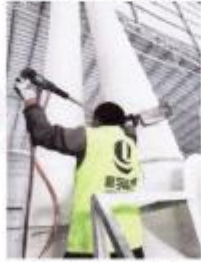
雷蒙磨机 4#废气 排放口 DA006
