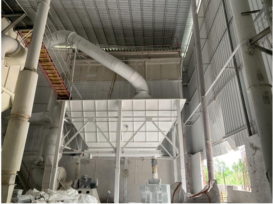
图 5 脉冲袋式除尘器（雷蒙磨机 5#无需设置排气筒，技术方案详见附件 6）
