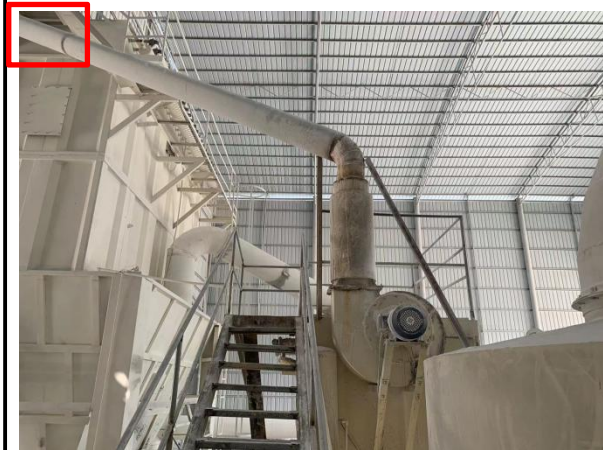
图 12 脉冲袋式除尘器、排气筒 DA007 及采样平台（厂区南侧分级机）
